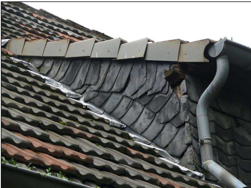
Abb. 15 Giebel mit beschädigter Schieferverkleidung, Gebäude 1
