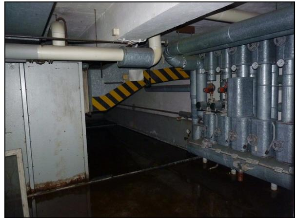
**Abb. 3-4: Blick in den Keller von Block 3 (Ausschnitte); am Boden steht bis zu mehr als 5 cm Wasser.**
