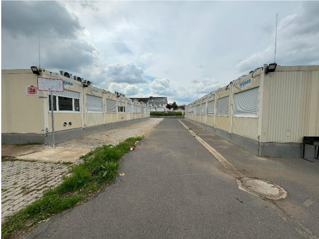
Abbildung 5: Zur Unterbringung von Geflüchteten genutzte Container in dem Vorhabenbereich.
