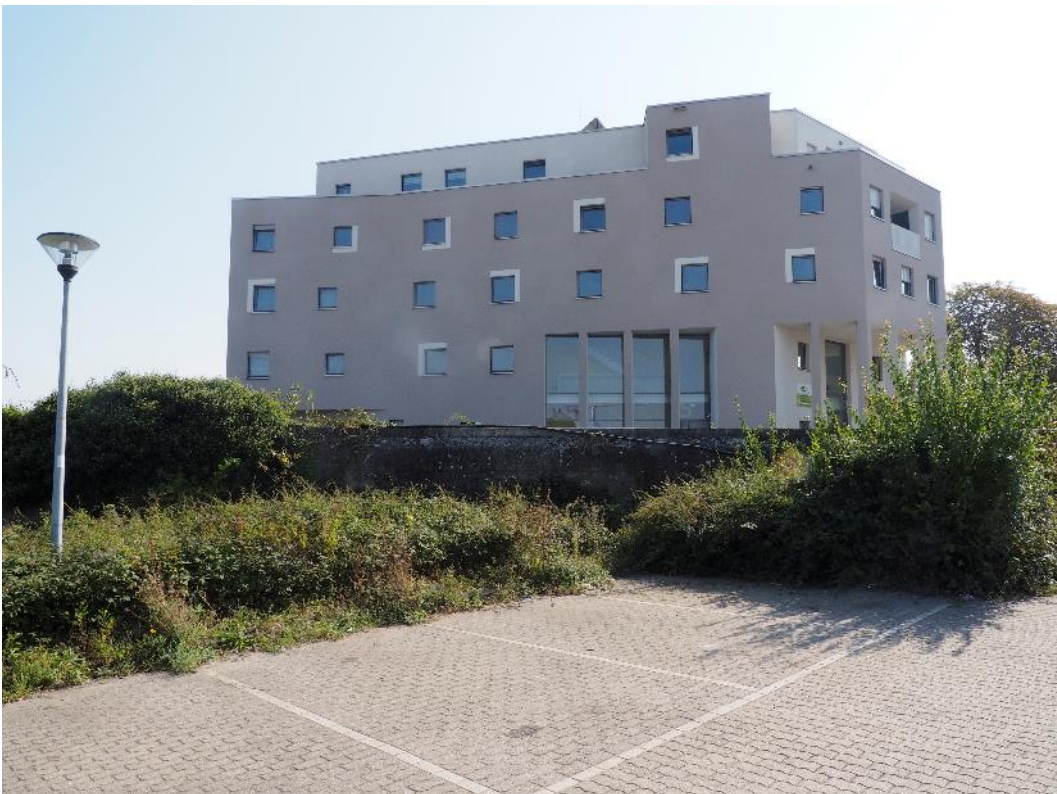
Abbildung 4: Blick auf eines der Gebäude am südlichen Rand des Vorhabenbereichs.
