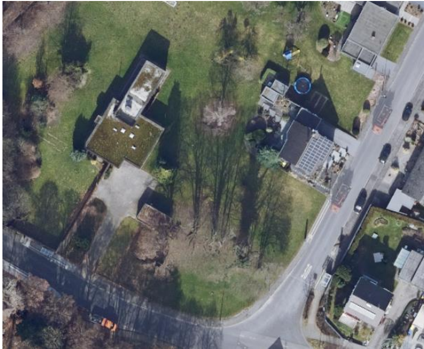
Luftbild vom Planbereich Fasanenstraße mit bereits abgerissenem Pastorat (Abriss erfolgte Anfang 2022), vor Neubau der neuen Kita St.Stephanus an gleicher Stelle ©Kreis Euskirchen, Abt. Geoinformation 2021; ohne Maßstab, genordet
