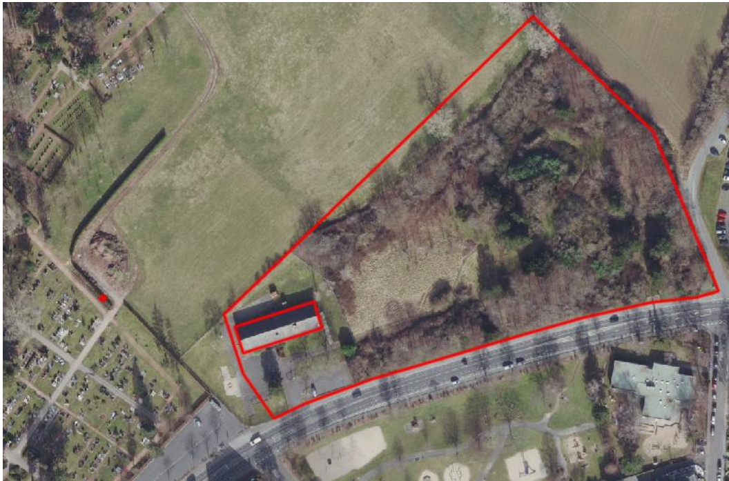
Baudenkmal Fernmeldebunker am Jülicher Ring ©Kreis Euskirchen, Abt. Geoinformation 2020
