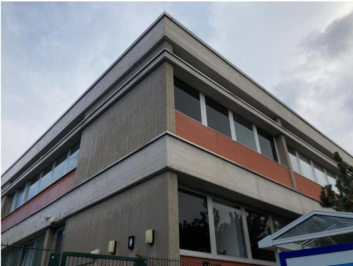
Abb. 1: Schulgebäude mit Abdeckblech an den horizontalen Kanten
