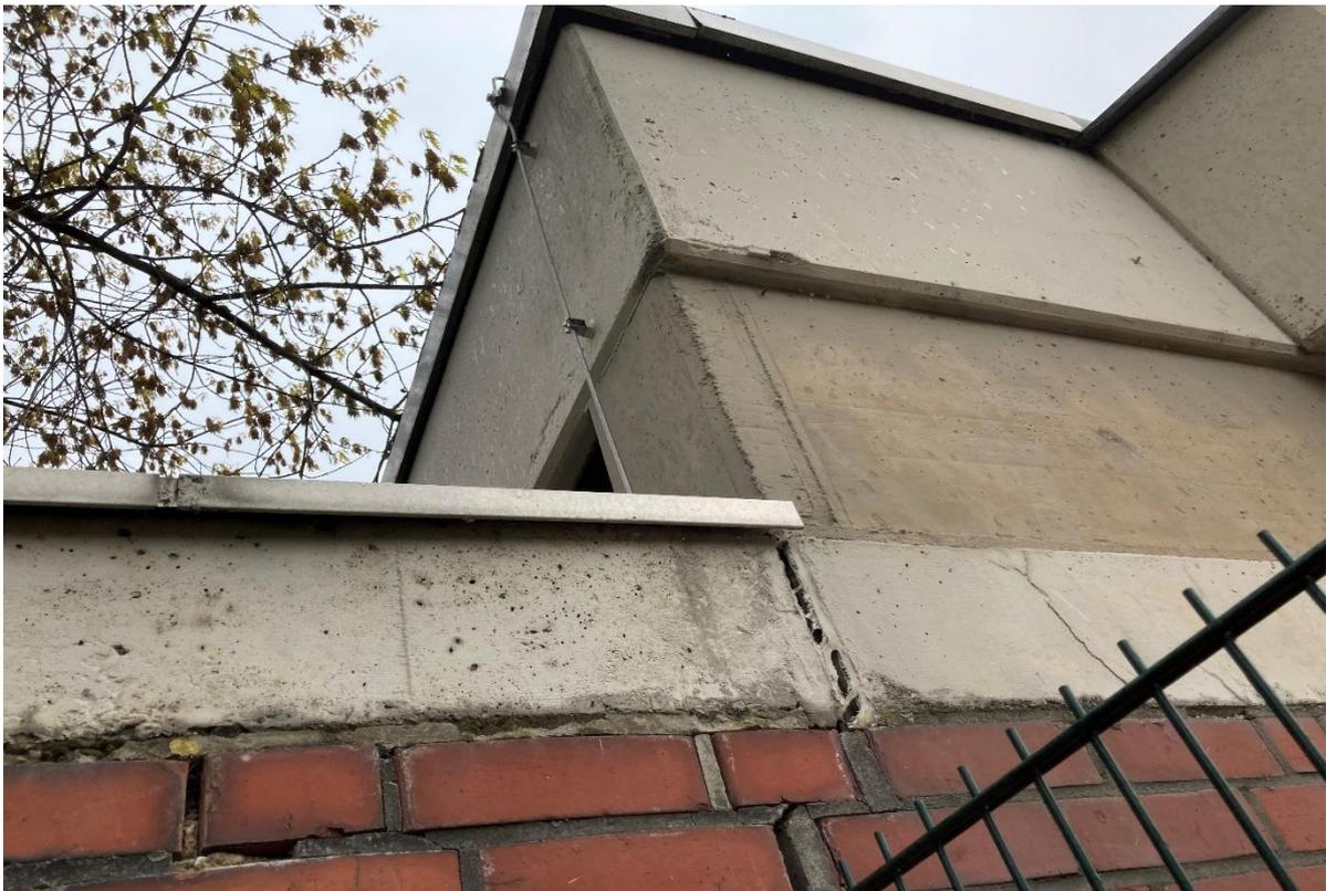
Abb. 5: Abstehendes Abdeckblech an der Dachkante, Mauerritzen
