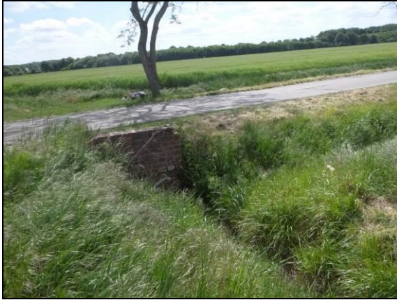
Abbildung 10: Euenheimer Fließ an der westlichen Straße.
