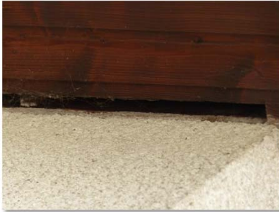
Abb. 11: Spalt in der Fassade
