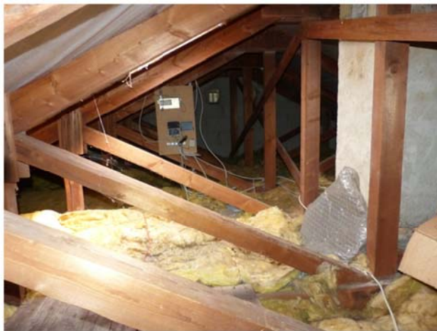
Abb. 10: gedämmter Dachstuhl
