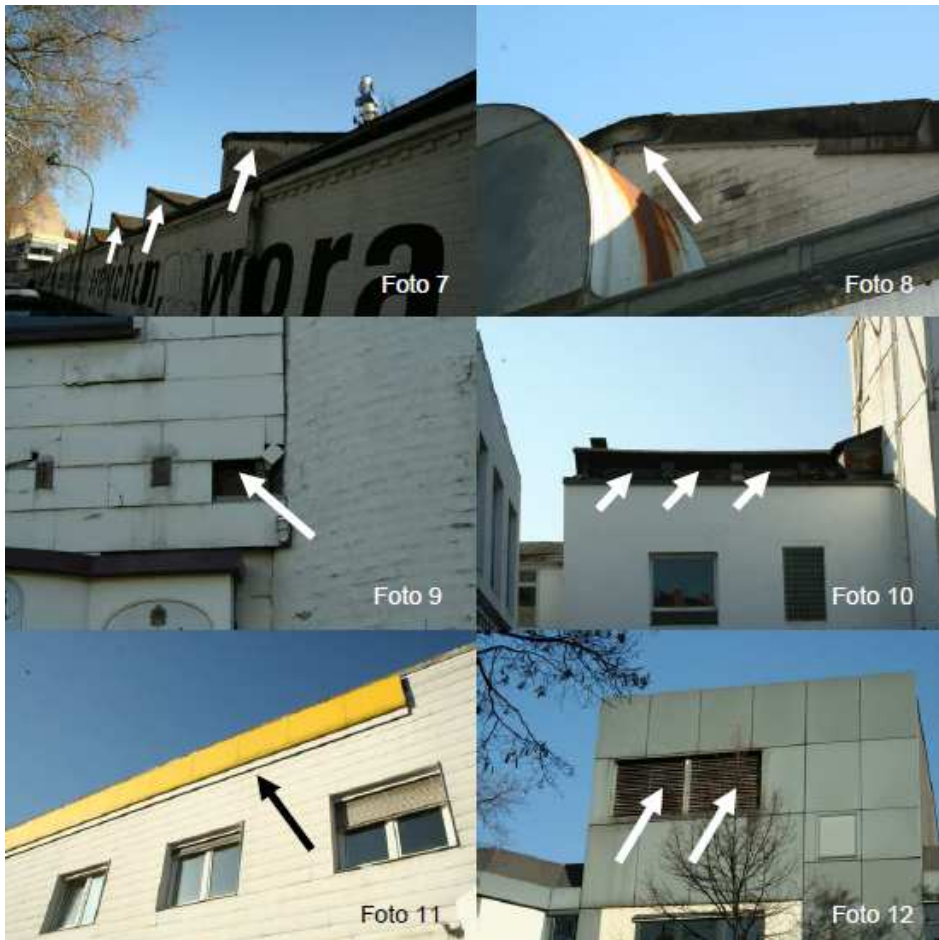
Foto 7-12: Beispiele für potenzielle Gebäudenutzung durch Fledermäuse im Bereich des Auto-Becker-Geländes.
