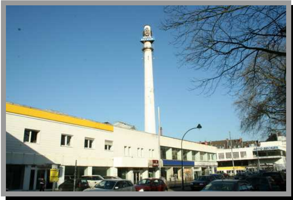
Foto 2: Forderfront des ehem. Auto-Becker-Geländes, im Hintergrund der Auto-Becker-Schornstein.
