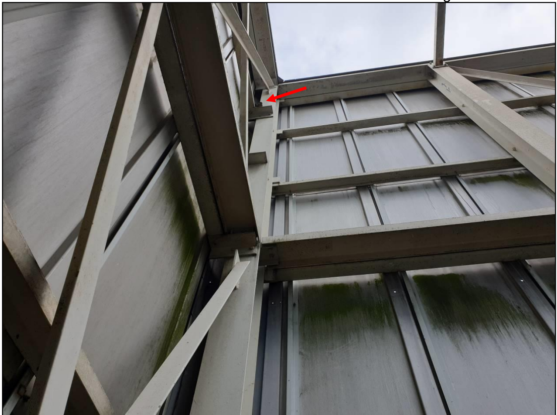
Foto 12: Taubennester innerhalb des oben offenen Teils des Aufzugsaufbaus
