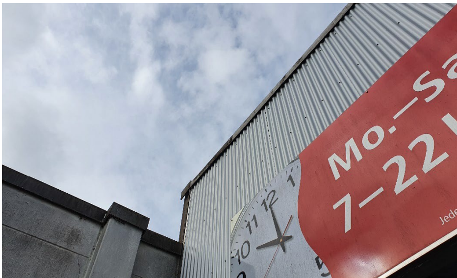
Blick auf die Attika des Nahversorgungsmarktes.
