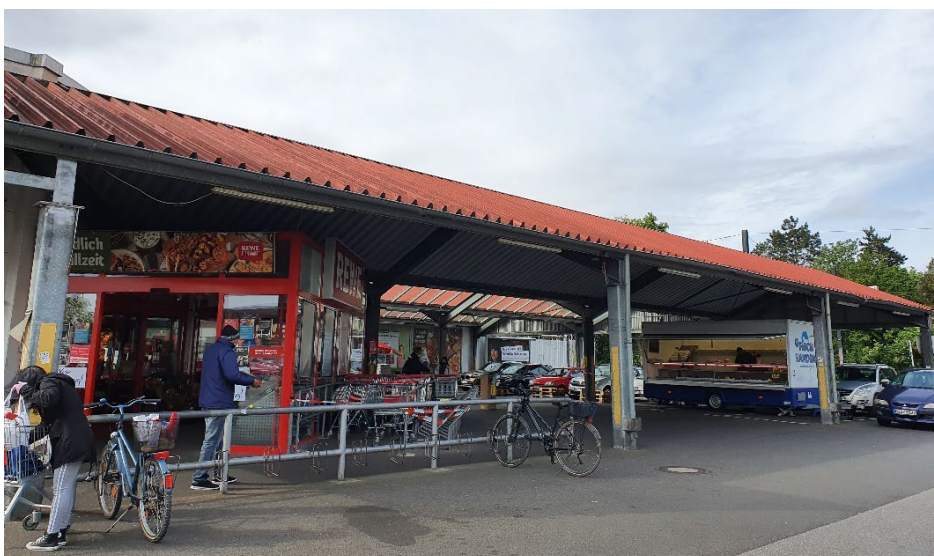
Blick auf die überdachte Pkw-Stellfläche von Nordosten.
