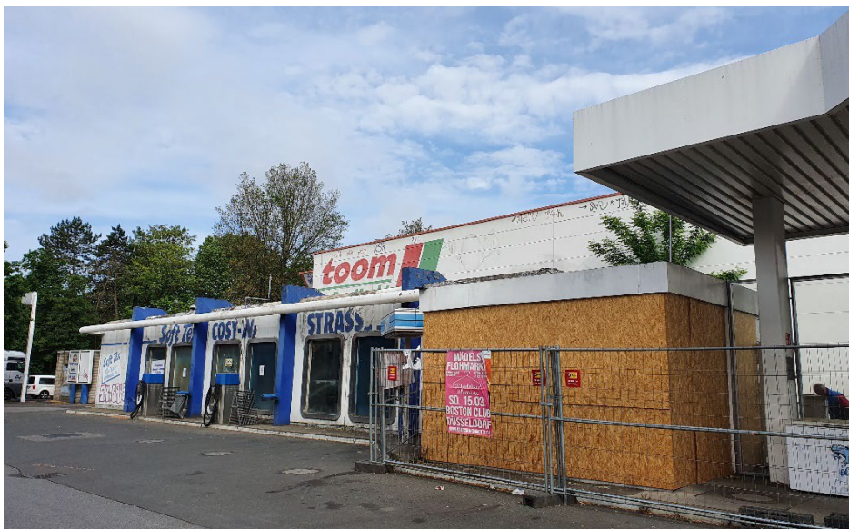
Blick auf die Waschstraße südlich des Baumarktes
