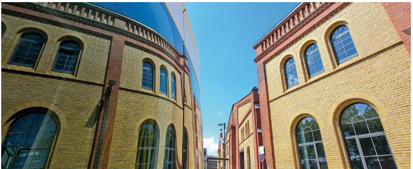
Das Gebäude der Netzgesellschaft Düsseldorf mbH, Höherweg 200
