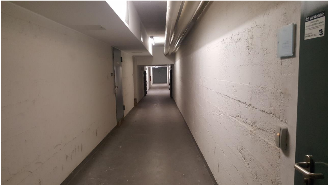
Abbildung 17: Blick in die Kellergänge in der Uerdinger Str. 67 in Düsseldorf.
