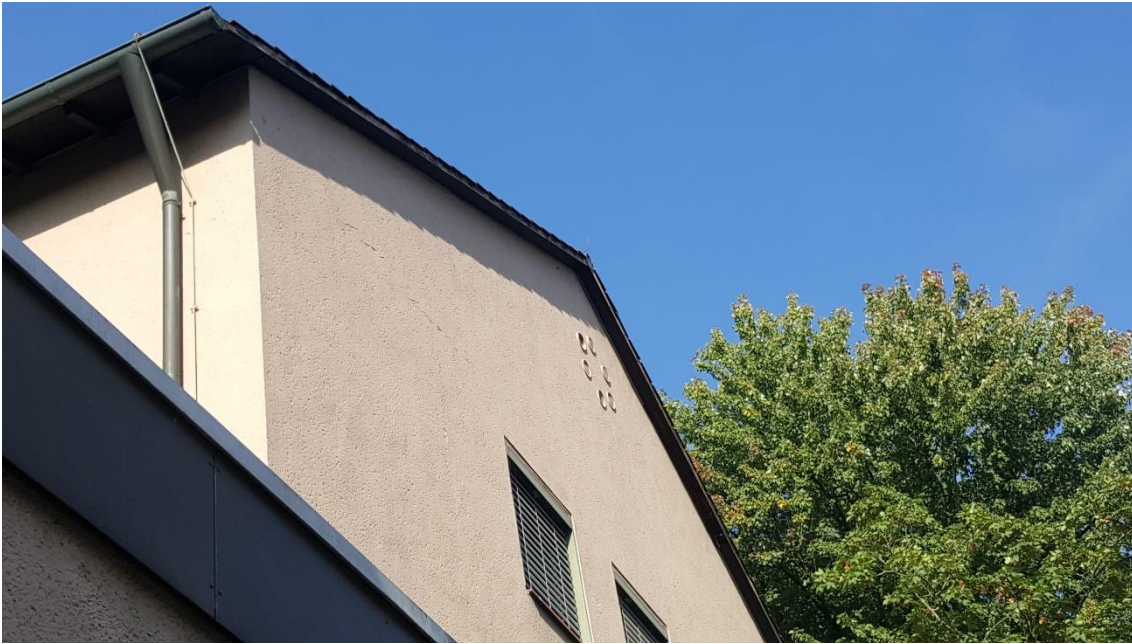
Abbildung 8: Blick auf die Ostseite des Gebäudes.
