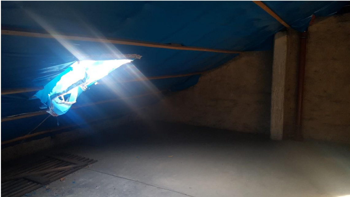
Abbildung 14: Die Fenster am Dachboden waren zum Zeitpunkt der Begehung geschlossen.
