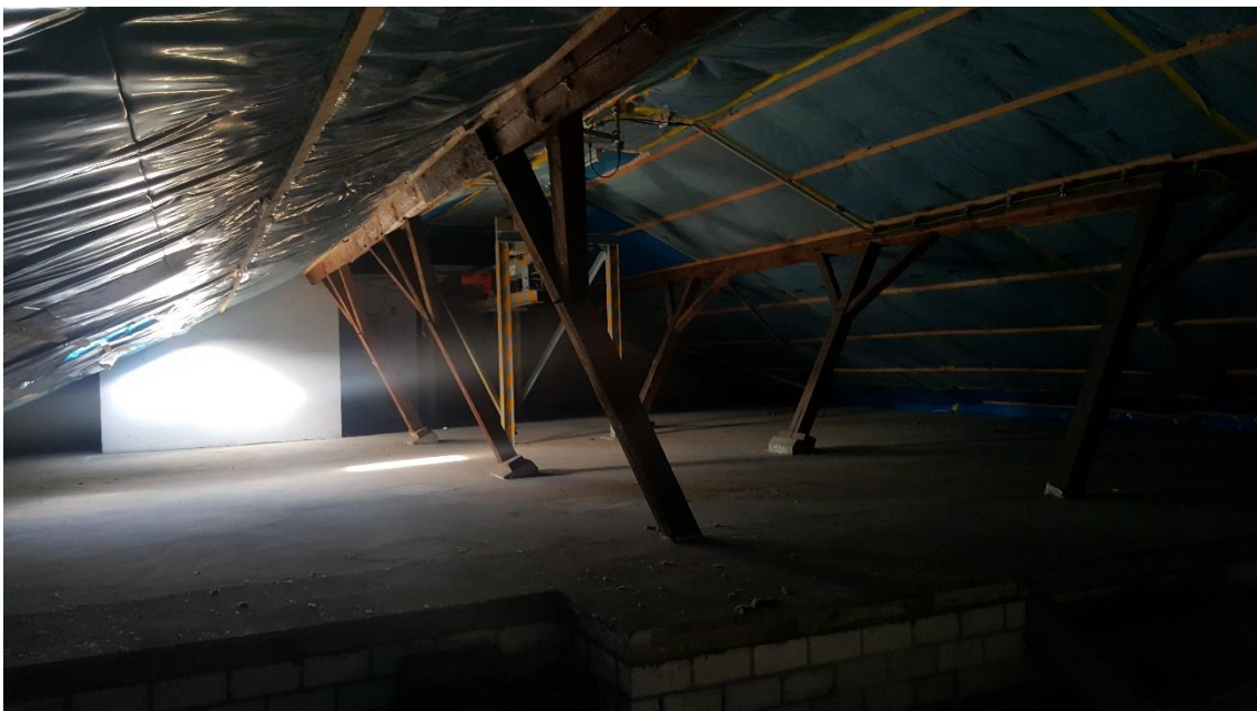
Abbildung 13: Blick in den Dachboden in der Uerdinger Str. 67 in Düsseldorf.
