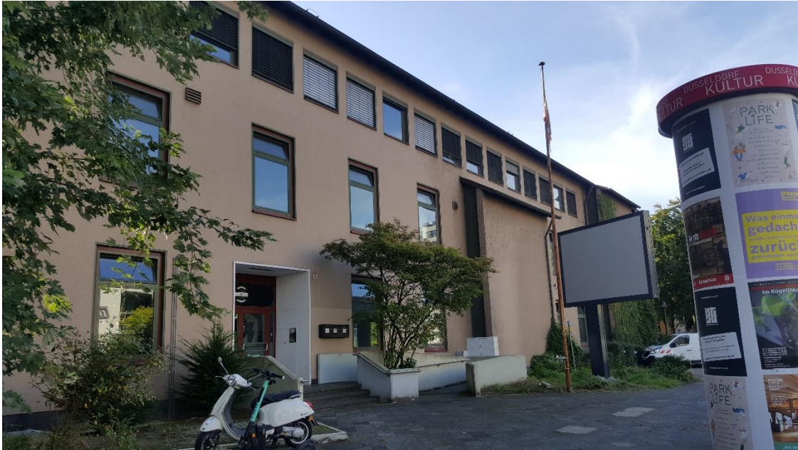
Abbildung 5: Blick auf die Nordostseite des vom Vorhaben betroffenen Gebäudes.
