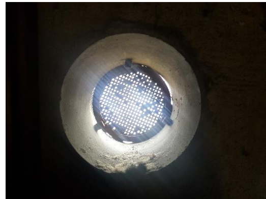
Abbildung 15: Auf dem Dachboden befinden sich Lüftungslöcher, die mit Gittern verschlossen sind.
