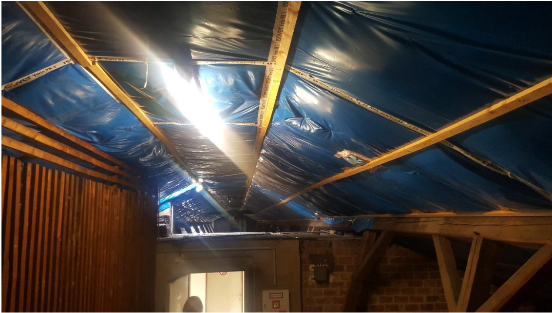
Abbildung 12: Der Dachboden ist isoliert und mit Plane abgedichtet.
