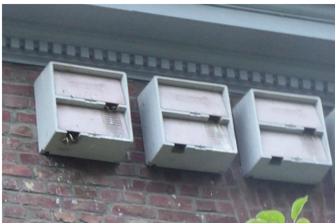
Schwalbenkästen an Fassade (Foto: Marius de Beer).
