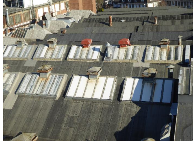
Abbildung 10: Blick auf die Dachkonstruktionen der Gebäude.
