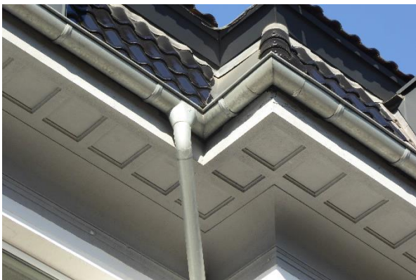
Abbildung 15: Blaumeise nutzt Hohlraum hinter der Regenrinne der Villa als möglichen Brutstandort.
