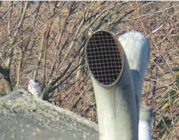
Abbildung 11: Die Lüftungsrohre und Öffnungen sind vergittert.
