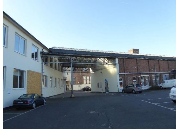
Abbildung 4: Blick in den Innenhof aus nordöstlicher Richtung.
