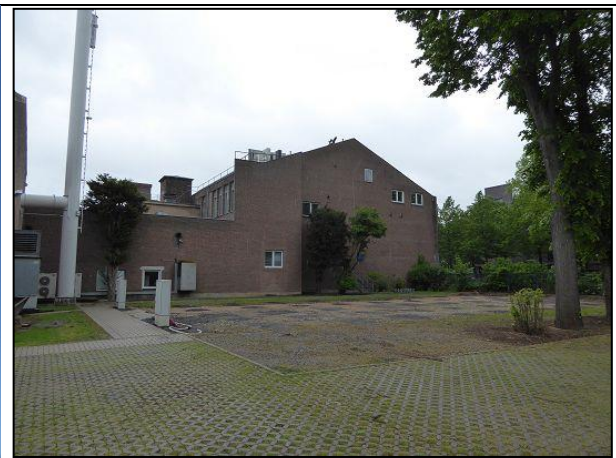
Abbildung 6: Ansicht der Westseite des südlichen Gebäudes.
