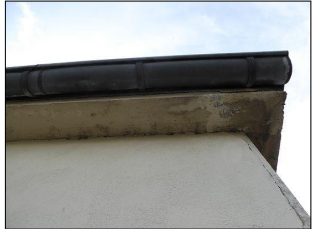
Abbildung 31: Der Dachabschluss ist aus gegossenem Beton und ohne Hohlräume.
