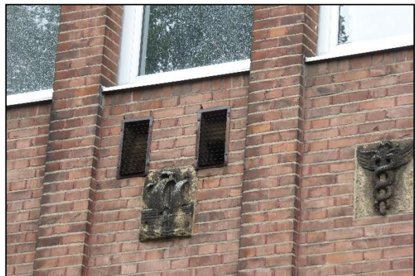
Abbildung 29: Blick auf Frontseite von der Hansaallee aus. Die vergitterten Belüftungsöffnungen bieten keine Einschulpmöglichkeiten. Zudem soll die Backsteinfassade erhalten bleiben.
