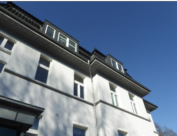
Abbildung 5: Blick auf die als Bürogebäude genutzte Villa.
