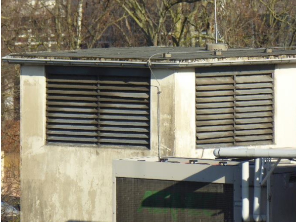
Abbildung 30: Die Belüftungsanlagen sind auch zum Zeitpunkt der zweiten Untersuchung mit feinmaschigen Netzen hinterlegt und bieten keine Einschluflmöglichkeiten.
