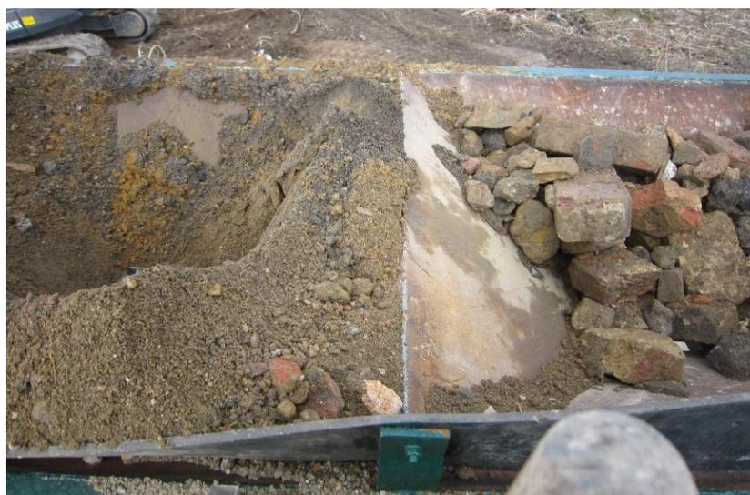
**Abbildung 3: Verstopfungen Trichtervorrichtung**
