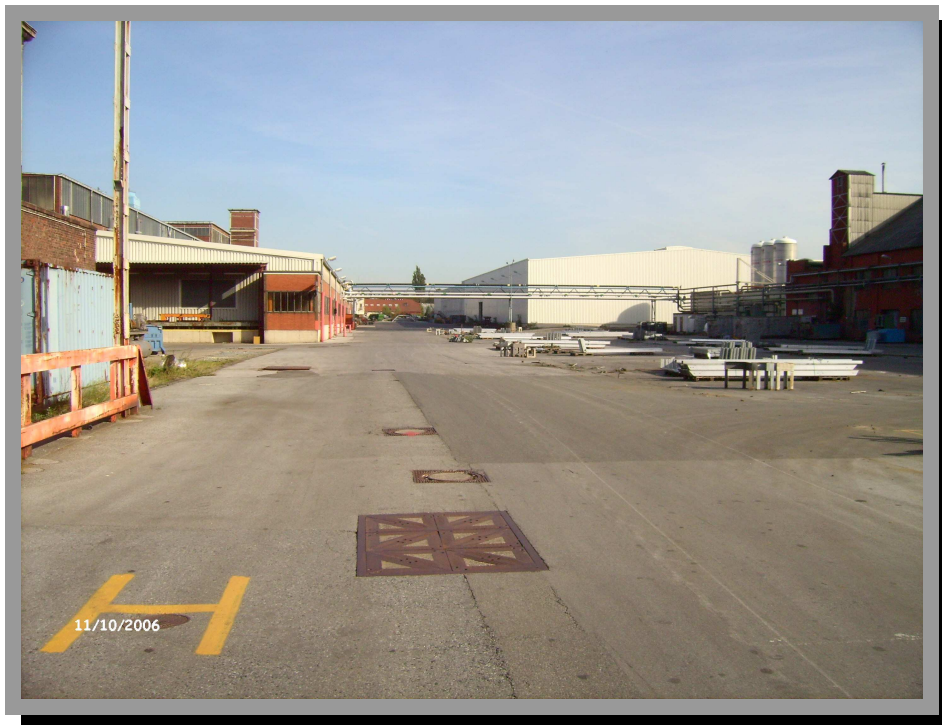
Foto 7: Charakteristischer Teilbereich der Fläche 5 - Glashütte Ost.
