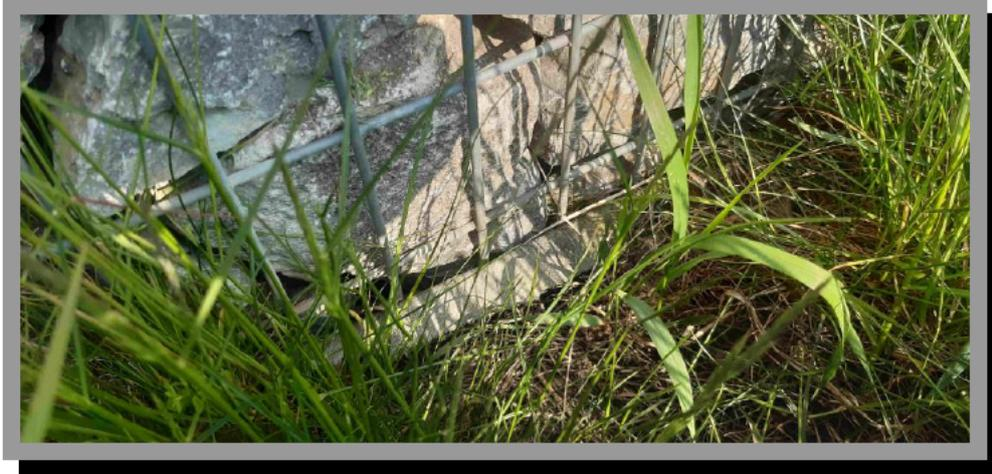
Foto 5: Ein Geotextil trennt das angeschüttete Erdreich von der Steinschüttung.
