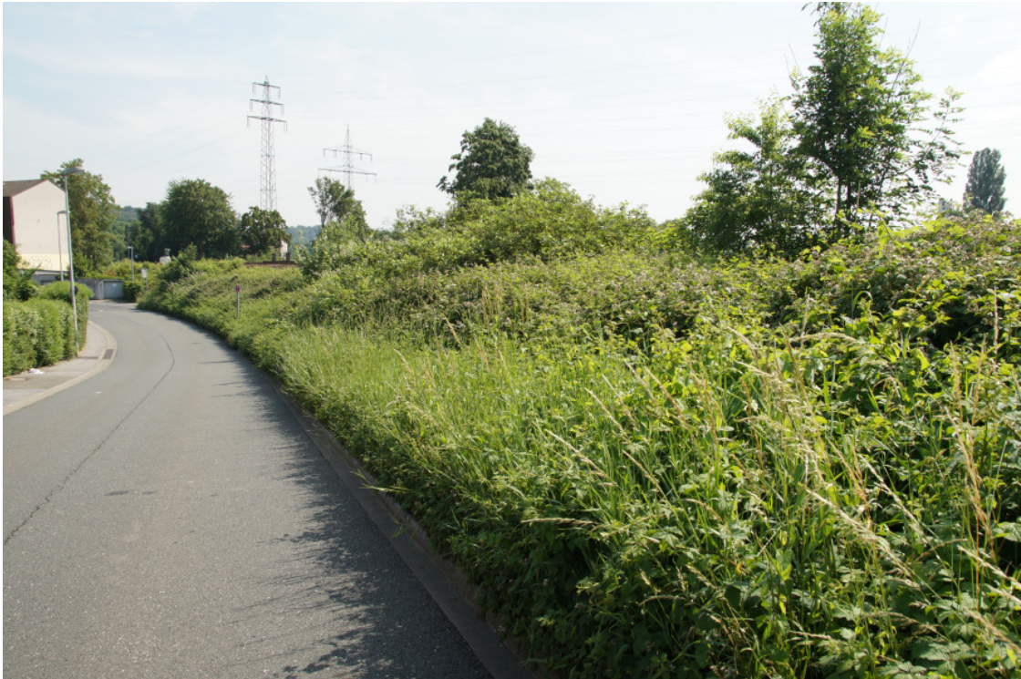
Abbildung 2 Bahndammböschung mit dichtem Bewuchs
