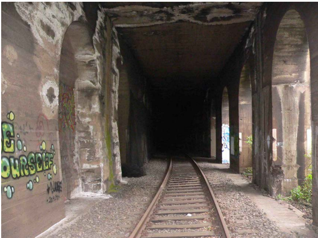
Abb. A3: Eine der beiden Unterführungen der stillgelegte Bahnstrecken im Einschnitt östlich des Plangebietes mit Funktion als Fledermaus-(winter-)quartier
