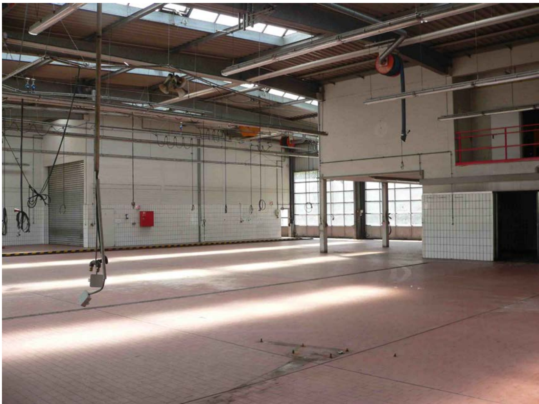
Abb. A13: Werkshallen im südlichen Plangebiet - Innenansicht
