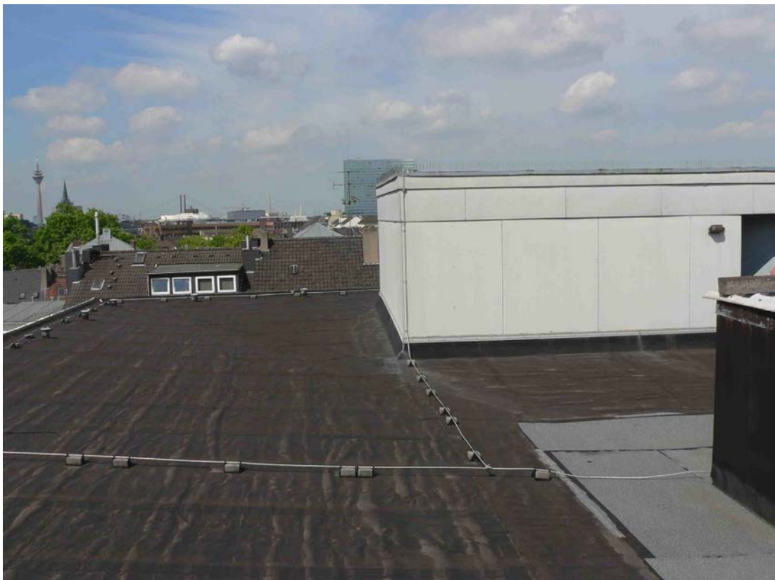
Abb. A9: Dachflächen der nördlichen Verwaltungsgebäude
