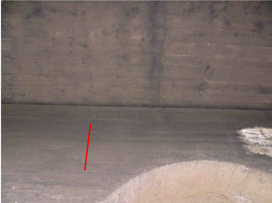
Abb. A4: Spalten zwischen den Betonplatten der Unterführungen der stillgelegten Bahnstrecke als Quartierstruktur für Fledermäuse
