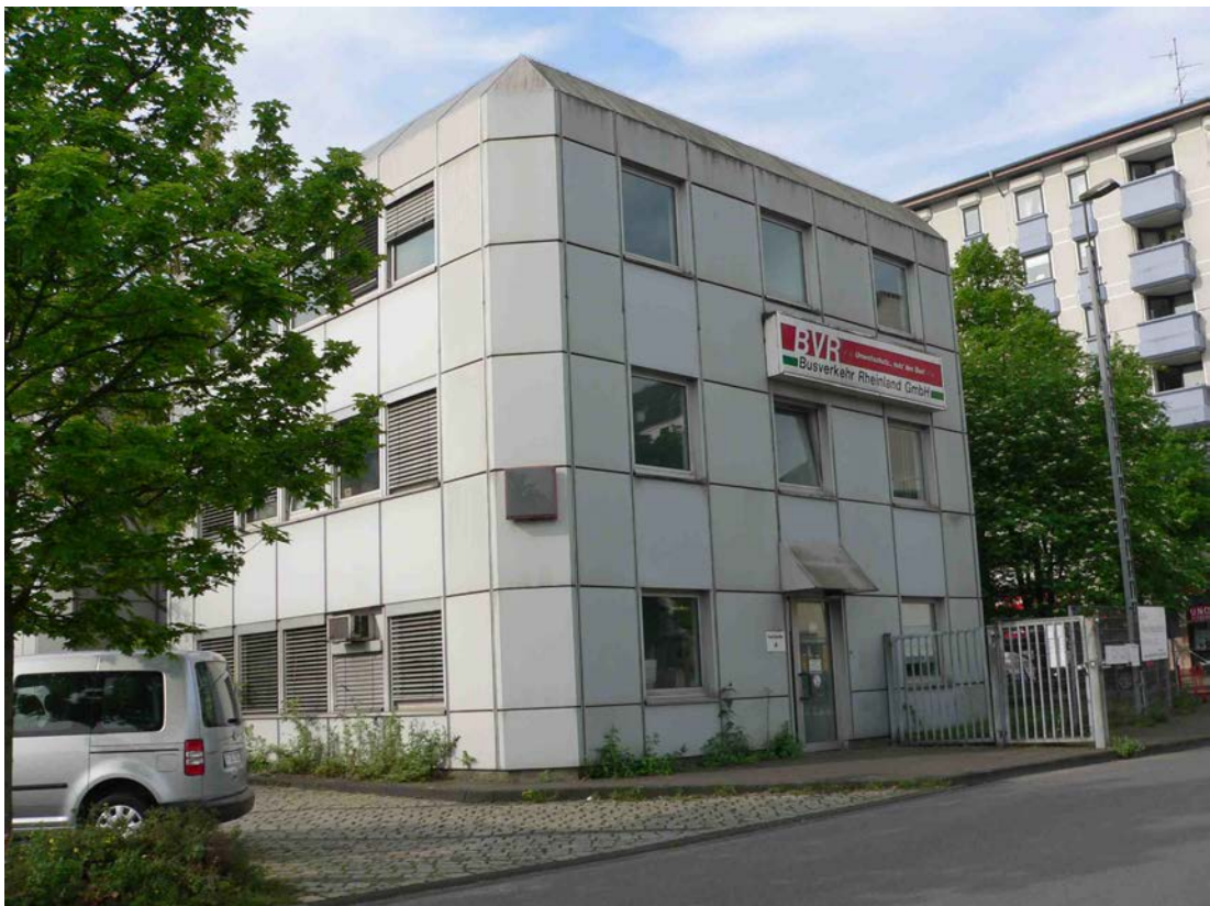
Abb. A11: Zum Teil noch genutztes Bürogebäude des BVR im Süden des Plangebietes
