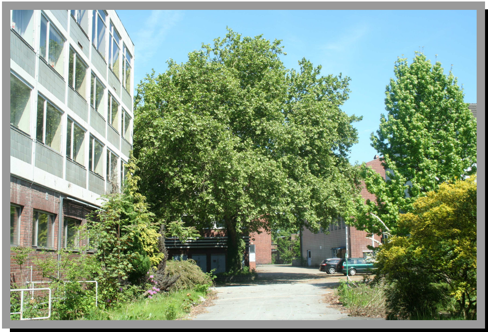
Foto 1: Im Bereich der fast völlig versiegelten Fläche der Werksanlage befinden sich einige ältere Gehölze.
