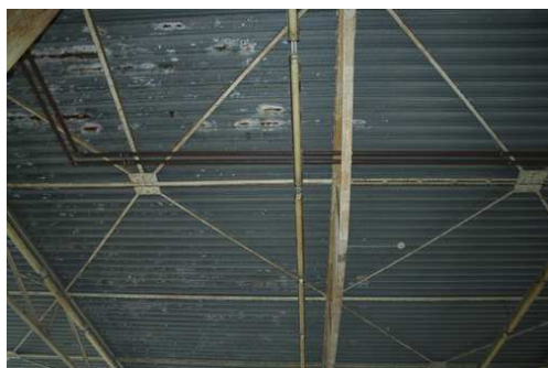
Foto 4: Der überwiegende Teil der Dachkonstruktionen, wie dieses Dach aus Profilblechen, ist als nicht fledermausfreundlich zu kennzeichnen.
