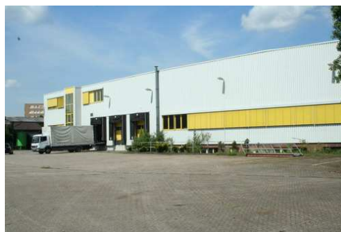
Foto 5: Hinter den schwer zugänglichen und isolierten Fassadenverkleidungen sind kaum Quartiermöglichkeiten für Fledermäuse gegeben.
