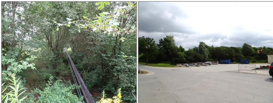
Abb. 7 Von Gehölzen umstandenes Förderband zum nördlichen Sandabbau (links) sowie gehölzbestandene Böschungs- und Übergangsbereiche nördliches Betriebsgelände zu Brachfläche (rechts)
