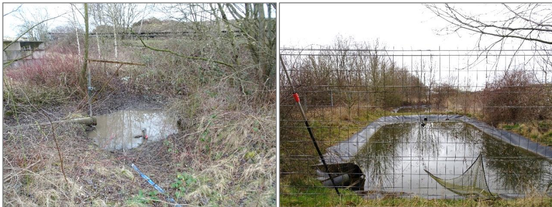
Abb. 8 Nördliches Absetzbecken (links) und südliches Absetzbecken (rechts) innerhalb des Plangebiets
